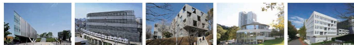
附属図書館 2011年 (意匠: 安田幸一 / 構造: 竹内徹) Library, 2011 (design by Koichi Yasuda / structure by Toru Takeuchi) 環境エネルギーイノベーション棟 2012年 (意匠: 塚本由晴 / 構造: 竹内徹 / 環境: 伊原学、湯浅和博) Environmental Energy Innovation Bldg. 2012 (design by Yoshiharu Tsukamoto / structure by Toru Takeuchi / environment by Manabu Ihara, Kazuhiro Yuasa) 緑が丘6号館 2013年 (意匠: 奥山信一 / 構造: 竹内徹) Midorigaoka Bldg. 6, 2013 (design by Shinichi Okuyama / structure by Toru Takeuchi) すずかけホール 2003年 (意匠: 仙田満 / 構造: 和田章) Suzukake Hall, 2003 (design by Mitsuru Senda / structure by Akira Wada) 元素戦略研究センター 2015年 (意匠: 村田涼、安田幸一 / 構造: 竹内徹) Materials Research Center for Element Strategy 2015 (design by Ryo Murata, Koichi Yasuda / structure by Toru Takeuchi)
