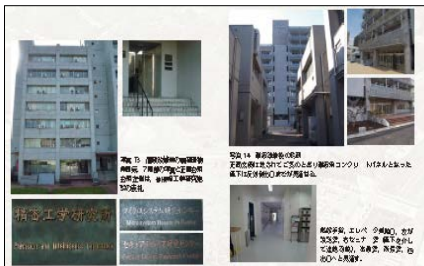
図8 耐震補強工事によるR2棟のバリアフリー化
