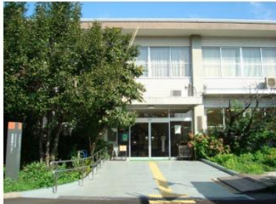
東京工業大学保健管理センター Tokyo Institute of Technology Health Service Center
